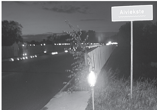
Aiviekstes tilts svecīšu liesmās.
