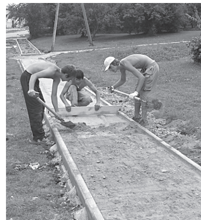
SIA „Madonas ceļu būve SIA” sagatavo ietvi bruģa ieklāšanai Avotu ielā.
